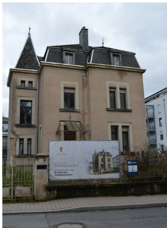
Die Villa Conter wird zum Stadtarchiv um- und ausgebaut
